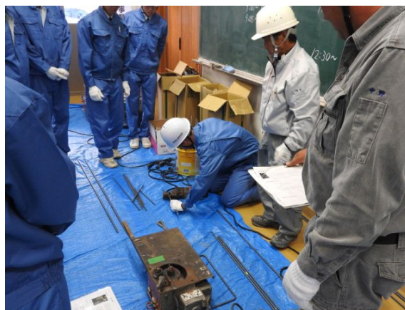
鉄筋加工の曲げ作業
