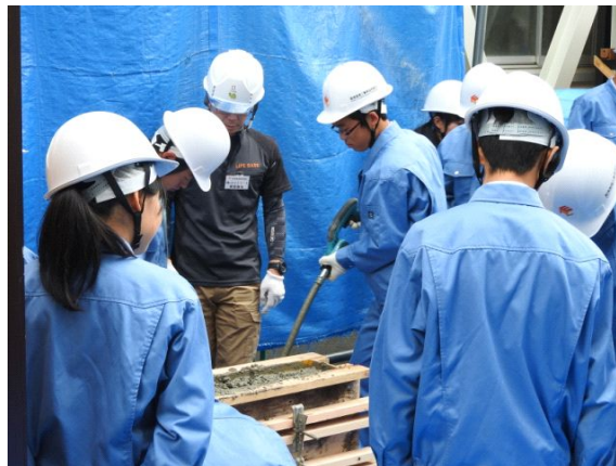
コンクリート打設の様子
