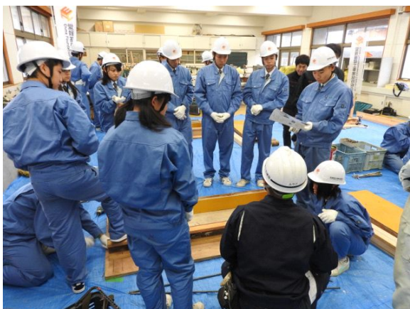
型枠の組み立て作業の様子
