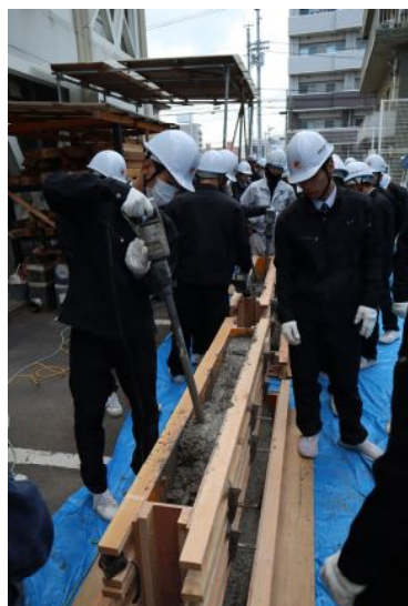
⑥コンクリート打設の様子
