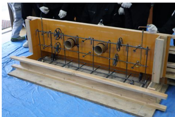
④完成した型枠内部
