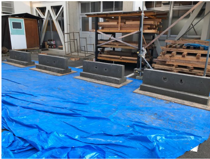
⑦完成した基礎
