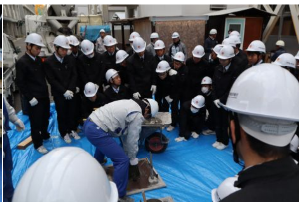
⑤コンクリート材料試験の様子
