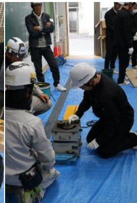
②鉄筋加工の様子
