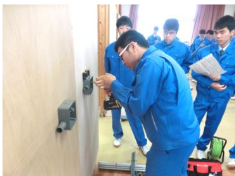
機器の取付作業
