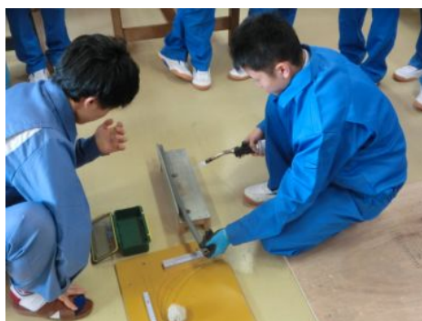
V E管の曲げ加工
