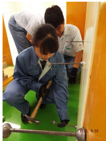
セパレーターの取り付け作業
