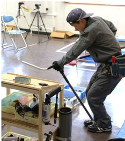
金属管の曲げ作業
