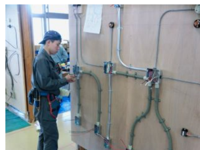
配線の端末接続作業
