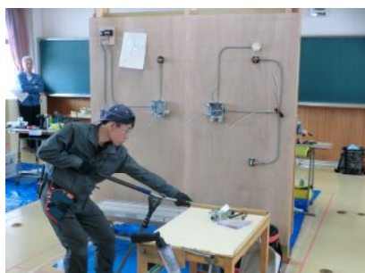
金属管の曲げ加工 電気科3年 森本 莞太君
