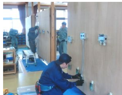
接続器具の取付作業
