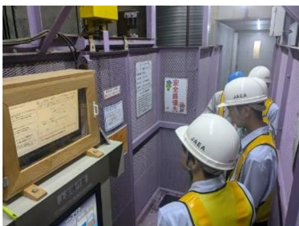
縦坑地下入口 (350m までのレベータ)
